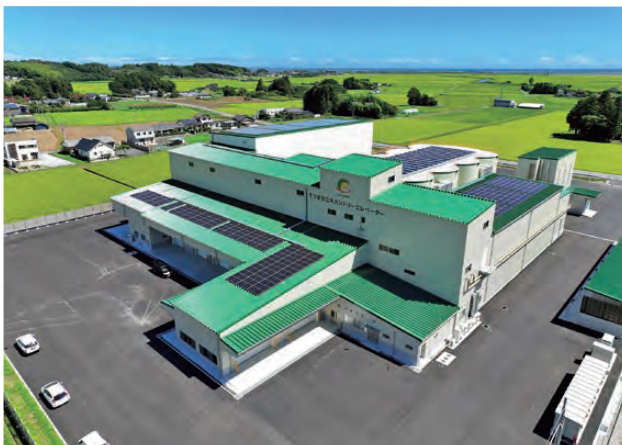
■そうま日立木 カントリーエレベーター
