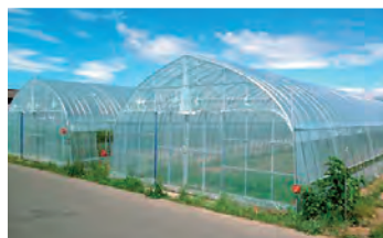
■ パイプハウスの新設
