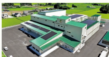
そうま日立木カントリーエレベーター
