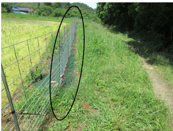
WM柵まわりに敷いた防草シート
